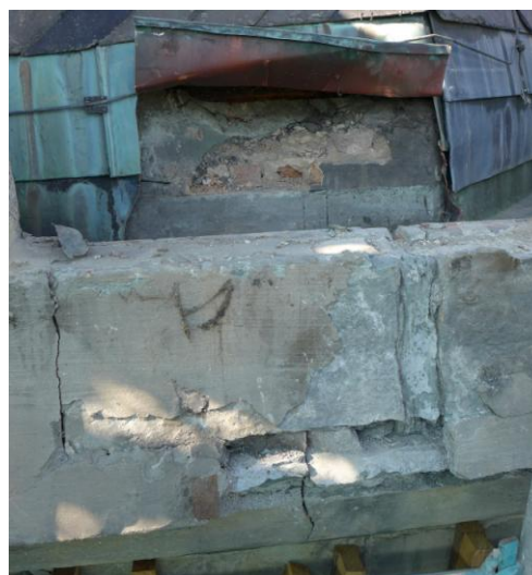
Mauerkrone u. Traufsims- von der Überdeckung freigelegt
